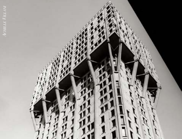
MILANO, LA TORRE VELASCA - ARCHITETTO ALINARI, FIRENZE
