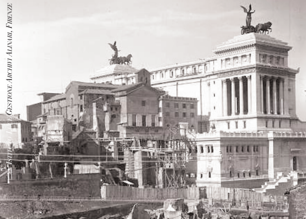
LAVORI PER LA COSTRUZIONE DELLA NUOVA STRADA DA PIAZZA VENEZIA AL COLOSSEO
