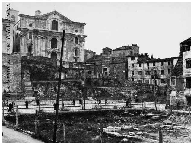
FACCIATA DELLA CHIESA DI S.MARIA MAGGIORE A TRIESTE. IN PRIMO PIANO L'AMPIO AVALLAMENTO CAUSATO DALLA RIMOZIONE DEL PALAZZO DI VETRO
