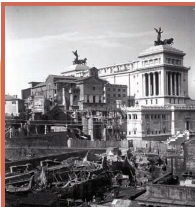
ROMA, LAVORI DI DEMOLIZIONE PER LA NUOVA STRADA DA PIAZZA VENEZIA AL COLOSSEO FOTO ISTITUTO LU CE/GESTIONE ARCHIVI ALINARI, FIRENZE
